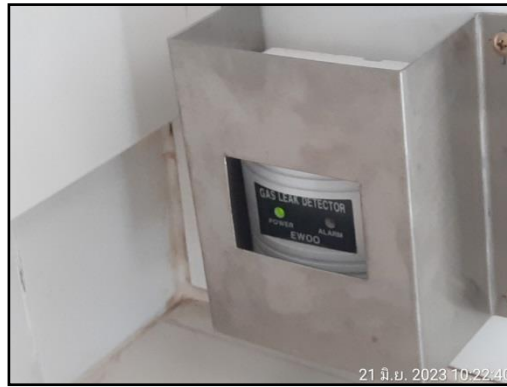
รูปที่ 40 Gas Leak Detector
