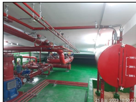
รูปที่ 44 ระบบน้ำสำรองเพื่อการดับเพลิง
