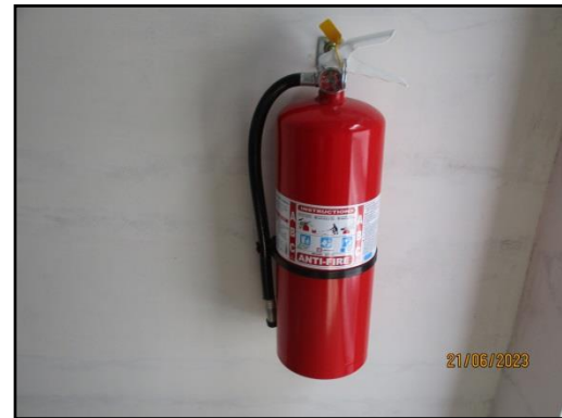
รูปที่ 41 ถังดับเพลิงแบบมือถือ
