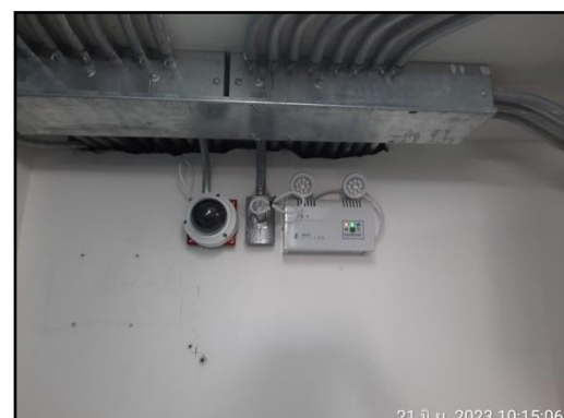
รูปที่ 39 ไฟฉุกเฉินอัตโนมัติ
