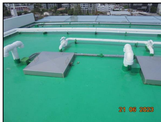
รูปที่ 13 ถังสำรองน้ำใช้ชั้นคาเฟ่
