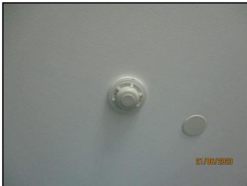
รูปที่ 37 อุปกรณ์ตรวจจับควัน
