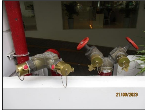
รูปที่ 43 ระบบท่อขึ้น หัวรับจ่ายน้ำดับเพลิง และตู้เก็บสายฉีดน้ำดับเพลิง
