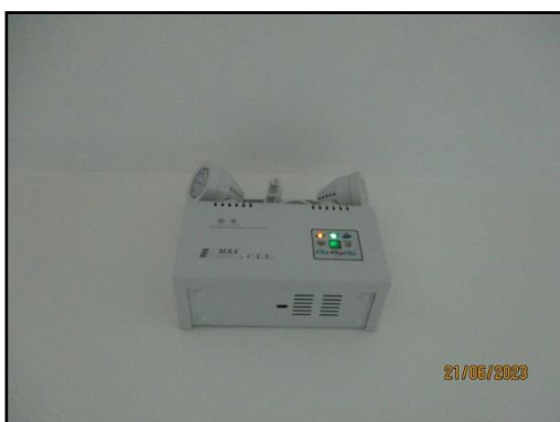
รูปที่ 39 ไฟฉุกเฉินอัตโนมัติ
