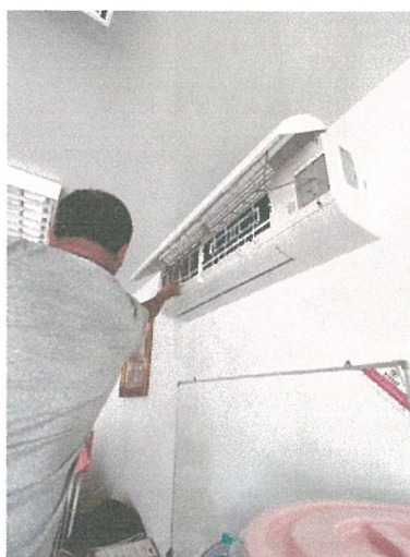
รูปภาพที่ 2.45 การทำความสะอาดเครื่องปรับอากาศ
