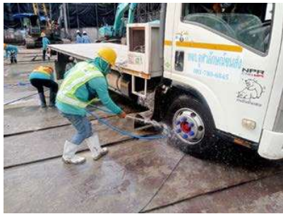
รูปที่ 29 ทำความสะอาดล้อรถบรรทุก
