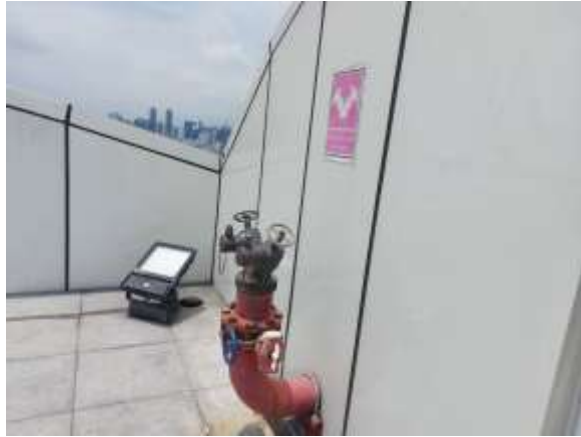
รูปที่ 37 ระบบหัวจ่ายน้ำดับเพลิง
