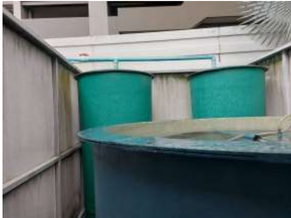
รูปที่ 13 ถังเก็บก๊าซมีเทน
