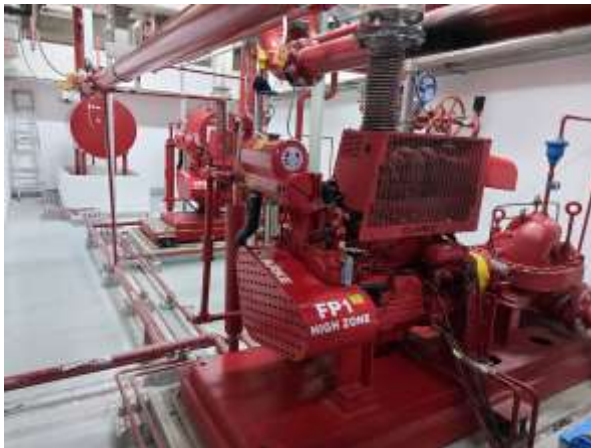
รูปที่ 33 เครื่องสูบน้ำดับเพลิง
