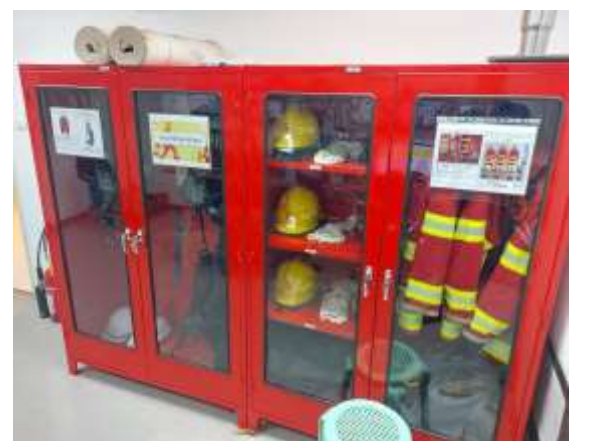
รูปที่ 36 ตู้เก็บสายฉีดน้ำดับเพลิงพร้อมอุปกรณ์
