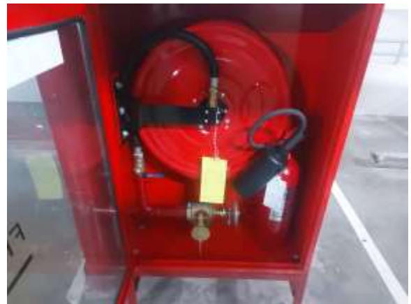
รูปที่ 16 ตรวจสอบถังดับเพลิงเคมี
