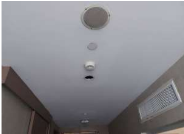
รูปที่ 43 กรังสัญญาณเตือนอัคคีภัย
