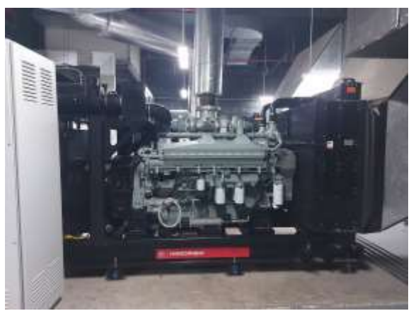
รูปที่ 24 ออกแบบเครื่องห้องไฟฟ้าและห้องเครื่องกำเนิดไฟฟ้า
