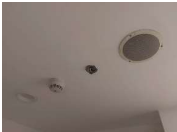
รูปที่ 41 เครื่องตรวจจับความร้อน
