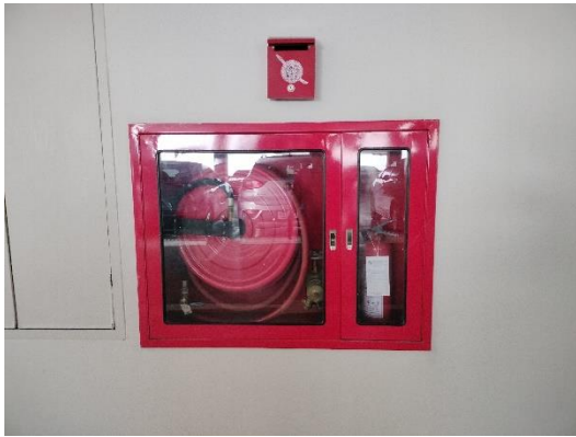
รูปที่ 19 ตู้เก็บสายฉีดน้ำดับเพลิงพร้อมอุปกรณ์
