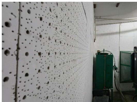
รูปที่ 30 วัสดุดูดซับเสียงในห้องเครื่องปั่นไฟ
