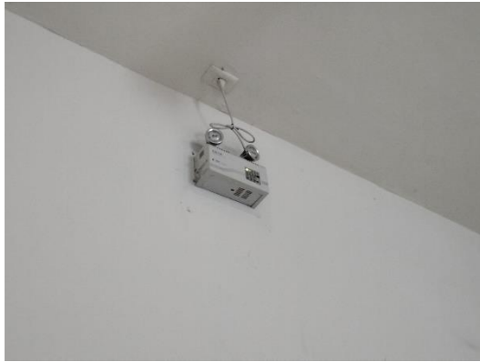
รูปที่ 31 ไฟส่องสว่างฉุกเฉิน
