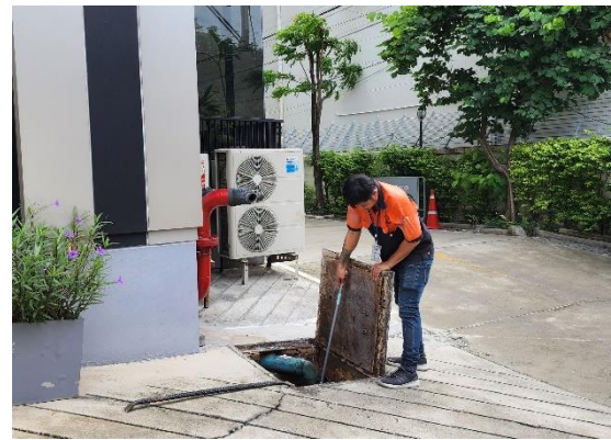
รูปที่ 22 ขุดลอกทรายระบายน้ำภายในโครงการ
