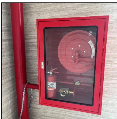
ภาพที่ 51 (ต่อ) อุปกรณ์แจ้งเตือน และดับเพลิงภายในโครงการ
