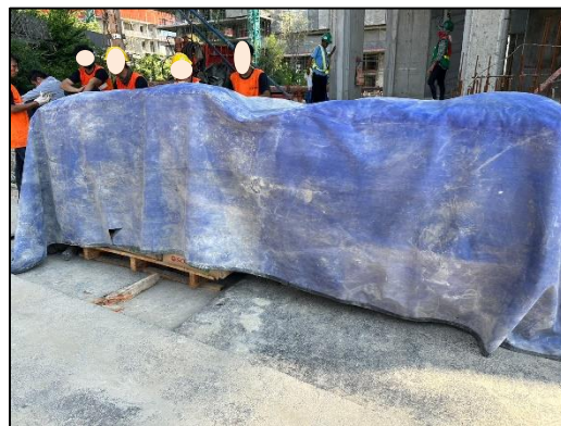
ภาพที่ 9 พื้นที่กองเก็บวัสดุก่อสร้างพร้อมผ้าใบปิดคลุมมิดชิด
