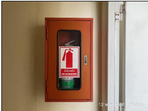
ภาพที่ 28 ถังดับเพลิงแบบมือถือ
