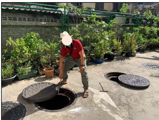
ภาพที่ 5 กิจกรรมตัดไขมันจากบ่อดักไขมัน
