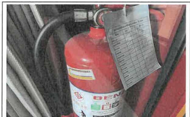
รูปที่ 3.1-14 การตรวจสอบสภาพถังดับเพลิงแบบมือถือ
