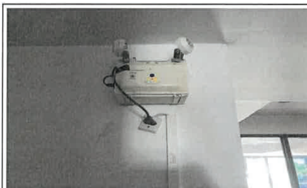
รูปที่ 3.1-16 ไฟฉุกเฉินอัตโนมัติชนิดแบตเตอรี่แห้ง
