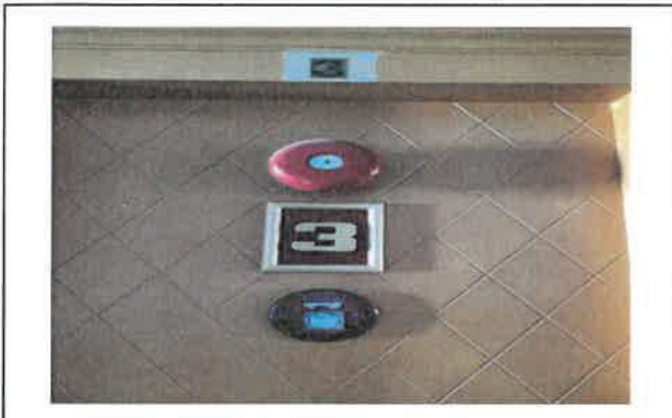
รูปที่ 3.1-13 อุปกรณ์แจ้งเหตุเพลิงไหม้แบบใช้มือกด/ดึง (Manual pull station) และอุปกรณ์แจ้งเหตุเตือนเพลิงไหม้ชนิดใช้ bell
