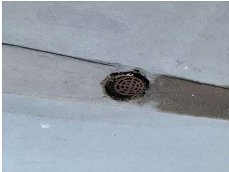
รางระบายน้ำและหัวรับน้ำฝน (RD) ชั้นดาดฟ้า
