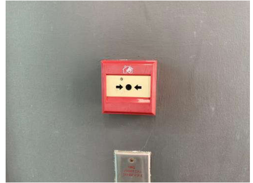
อุปกรณ์แจ้งเหตุเพลิงไหม้ด้วยมือ (Manual Station) และโทรศัพท์ฉุกเฉิน
