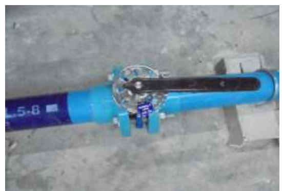
รูปที่ 6 วาล์วปิดก๊าซสะพานไฟฟ้า
