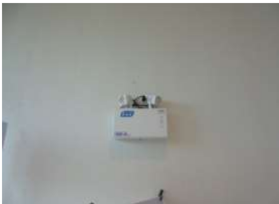
รูปที่ 35 ระบบสำรองไฟส่องสว่างฉุกเฉิน
