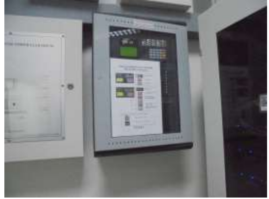
รูปที่ 38 แผงควบคุมระบบแจ้งเหตุเพลิงไหม้
