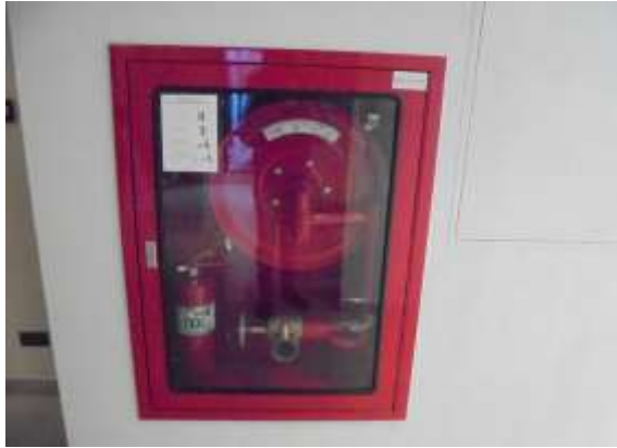
รูปที่ 43 ตู้เก็บสายน้ำดับเพลิง
