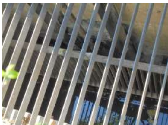
รูปที่ 23 ตะแกรงดักมูลฝอย
