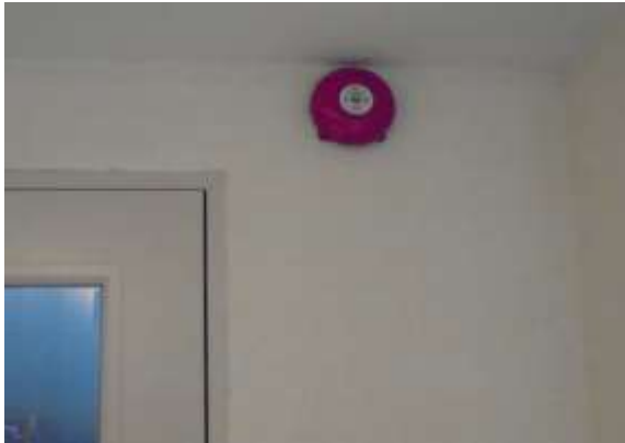
รูปที่ 39 อุปกรณ์ส่งสัญญาณหนีไฟ
