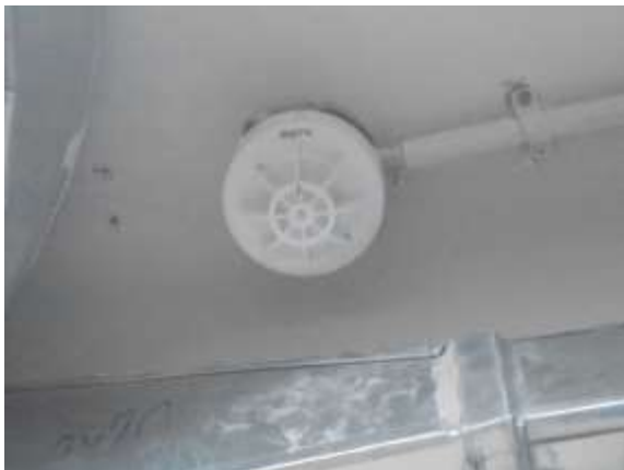
รูปที่ 41 เครื่องตรวจจับควัน
