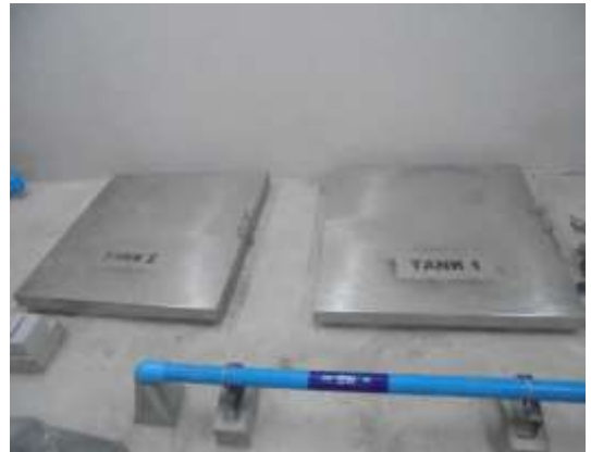
รูปที่ 8 ฝาบ่อเก็บน้ำใต้ดิน
