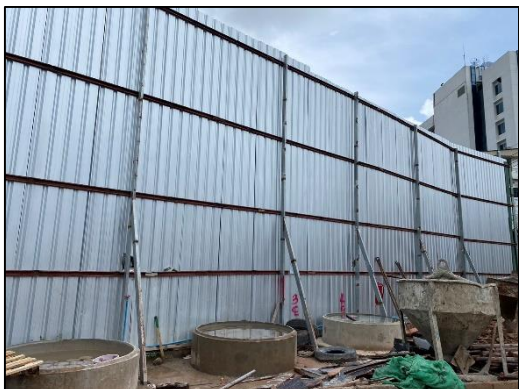
ภาพที่ 24 รั้ว Metal Sheet โดยรอบพื้นที่โครงการ
