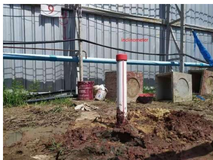
รูปที่ 10 การติดตั้ง Inclinator
