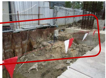
รูปที่ 8 ผนังกันดิน (Sheet Pile)
