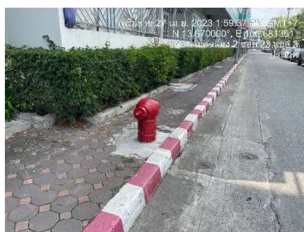
รูปที่ 22 ท่อจ่ายน้ำดับเพลิง
