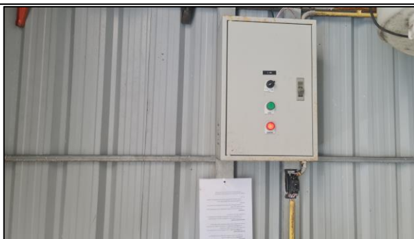
รูปที่ 2-7 การติดตั้งตู้ควบคุมไฟฟ้าระบบบำบัดน้ำเสีย
