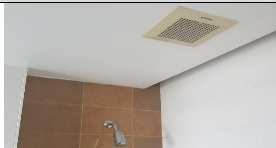
รูปที่ 2-27 การติดตั้งพัดลมระบายอากาศในห้องพักและในห้องน้ำ
