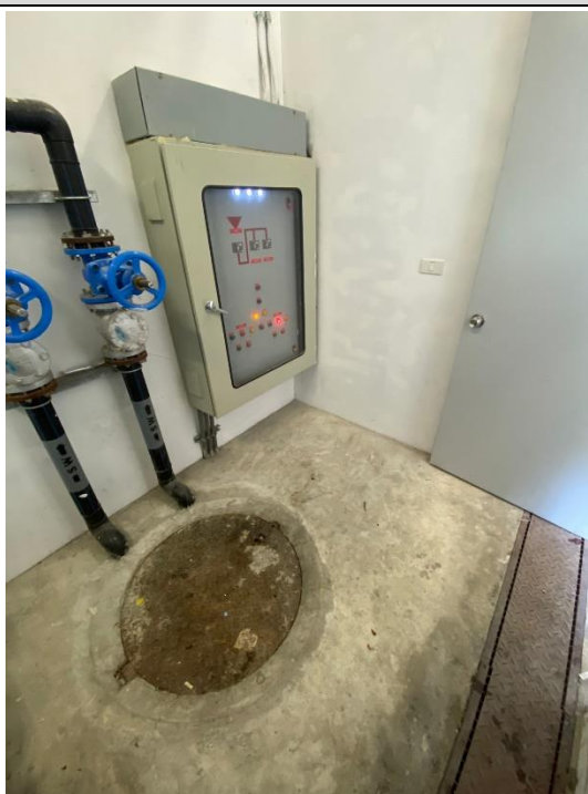
รูปที่ 2-14 รางรวบรวมน้ำเสียจากห้องพัสดุปล่อยเข้าสู่ระบบบำบัดน้ำเสีย
