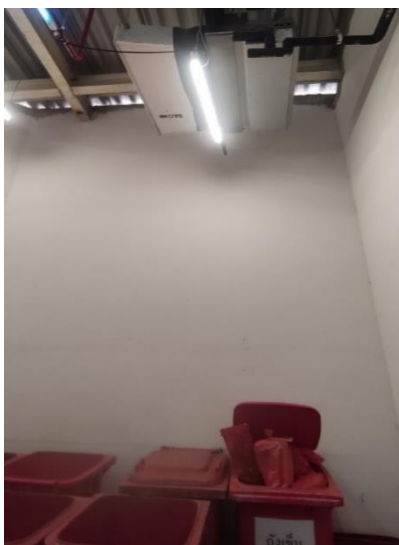
รูปที่ 2-17 การติดตั้งเครื่องปรับอากาศภายในห้องพักมูลฝอยติดเชื้อ
