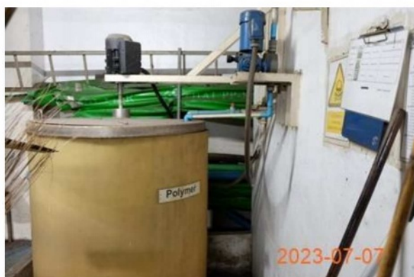
(7) เครื่องเติมสารโพลีเมอร์ (Polymer Feed)
