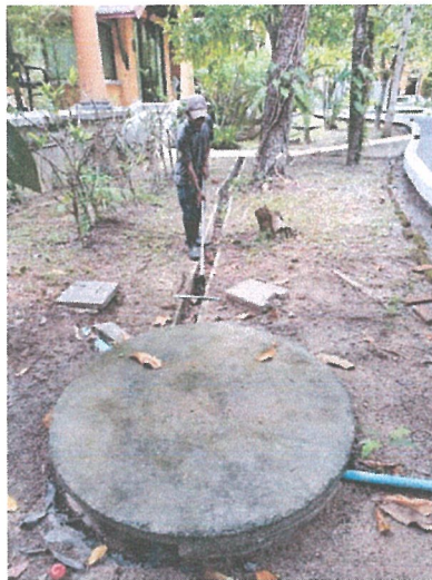
รูปภาพที่ 2.15 การขุดลอกตะกอน
