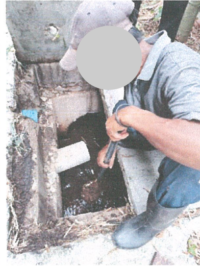
รูปภาพที่ 2.15 การขุดลอกตะกอน
