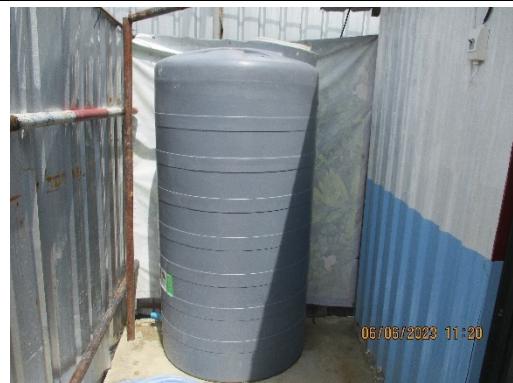
รูปที่ 14 ถังสำรองน้ำ สำหรับการพรมน้ำพื้นถนนชั่วคราวภายในโครงการ
