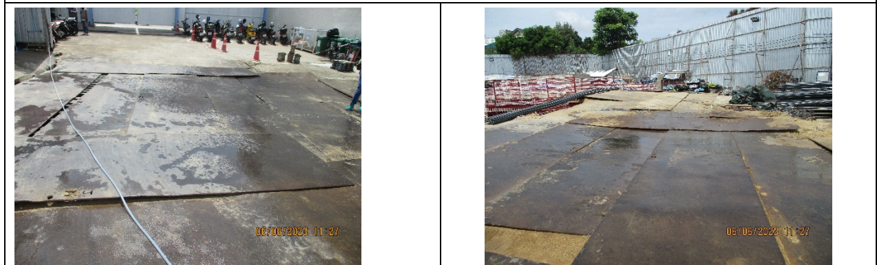
รูปที่ 69 โครงการจัดให้มีการปูแผ่นเหล็ก สำหรับใช้เป็นเส้นทางวิ่งของรถบรรทุกวัสดุก่อสร้างในพื้นที่โครงการ
