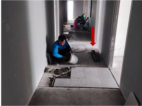
ภาพที่ 19 การใช้แท่นตัดกระเบื้องในการตัดกระเบื้อง
