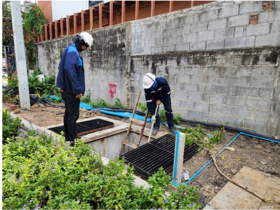
ภาพที่ 35 บ่อดักขยะก่อนระบายน้ำออกจากโครงการ
