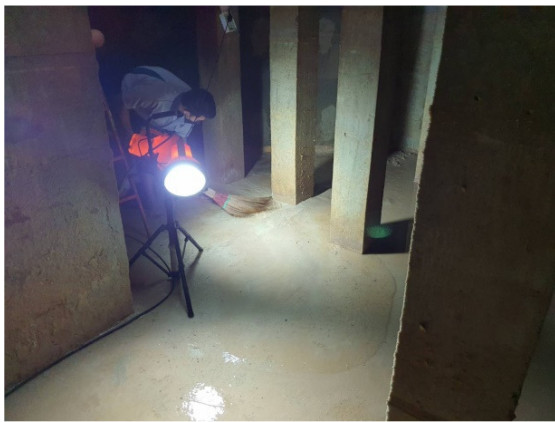
ล้างทำความสะอาดถังสำรองน้ำใช้
