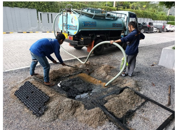
สูบน้ำก่อนระบบบำบัดน้ำเสียไปกำจัด
