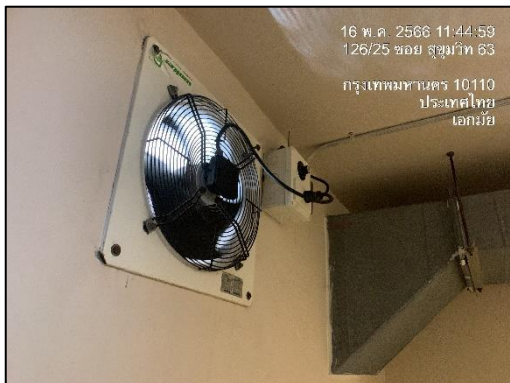
รูปที่ 14 พัดลมระบายอากาศ
