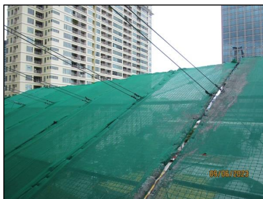
รูปที่ 49 Chain Link ขึ้นจากอาคารขณะทำโครงสร้าง
