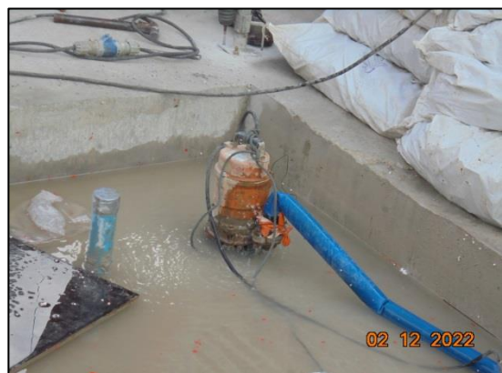
รูปที่ 26 เครื่องสูบน้ำ เพื่อสูบน้ำจากก่อสร้างชั้นใต้ดินเข้าสู่บ่อพักน้ำ ที่อยู่โดยรอบพื้นที่โครงการ
