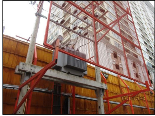
รูปที่ 33 หม้อแปลงไฟฟ้าในพื้นที่ก่อสร้าง เพื่อควบคุมปริมาณการใช้ไฟฟ้า
