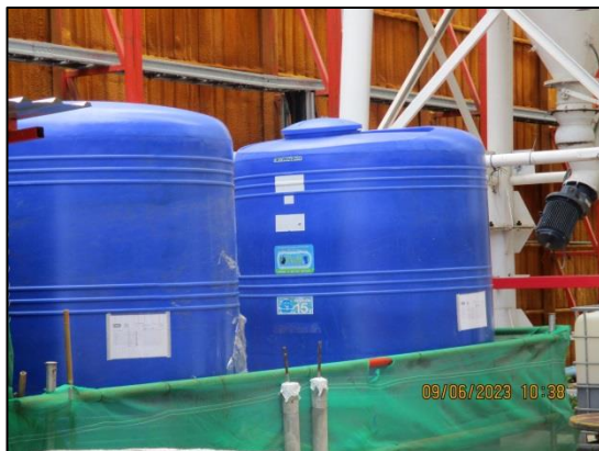
รูปที่ 23 ระบบบำบัดน้ำเสียชนิดเติมอากาศ จำนวน 1 ชุด
