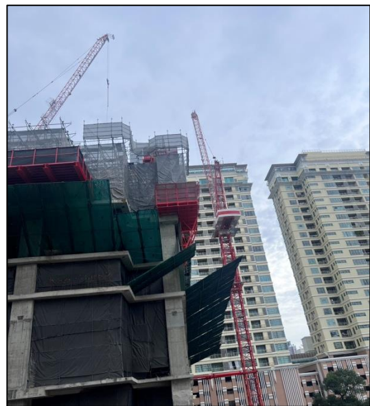
รูปที่ 50 เครน และทาวเวอร์เครนที่สามารถพับแขนได้ ติดตั้งเฉพาะภายในพื้นที่โครงการเท่านั้น
