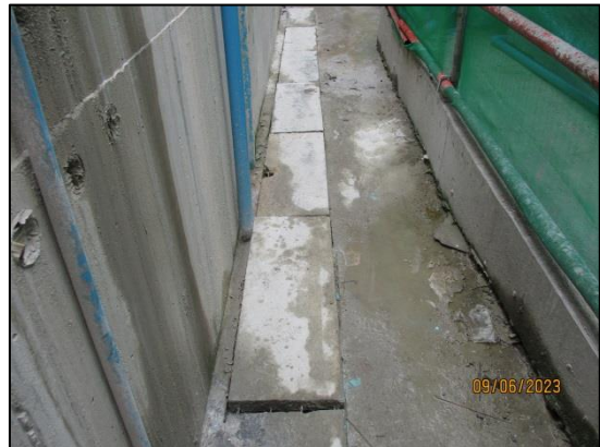
รูปที่ 25 รางระบายน้ำ บริเวณโดยรอบของพื้นที่โครงการ เพื่อรวบรวมน้ำเข้าสู่บ่อพักน้ำ
