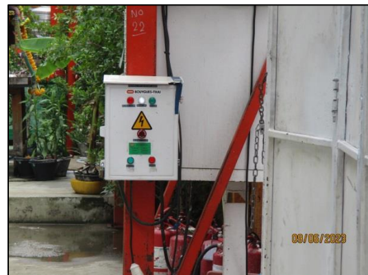
รูปที่ 41 ติดตั้งเครื่องแจ้งเหตุเตือนเพลิงไหม้ ด้วยเสียง Alarm Bell
