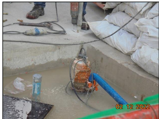
รูปที่ 25 รางระบายน้ำ บริเวณโดยรอบของพื้นที่โครงการ เพื่อรวบรวมน้ำเข้าสู่บ่อพักน้ำ
