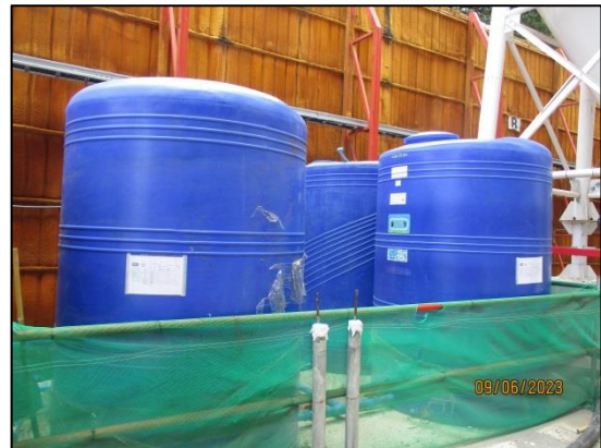
รูปที่ 23 ระบบบำบัดน้ำเสียชนิดเติมอากาศ จำนวน 1 ชุด
