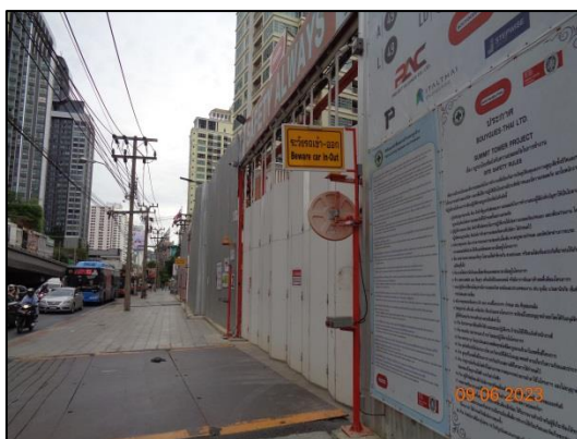
รูปที่ 41 ติดตั้งเครื่องแจ้งเหตุเตือนเพลิงไหม้ ด้วยเสียง Alarm Bell
