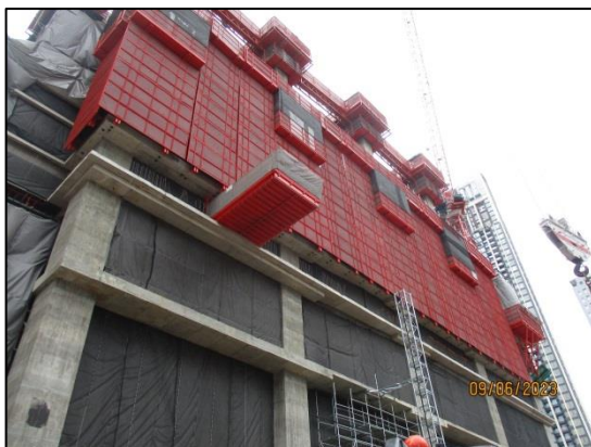
รูปที่ 13 ติดตั้ง Mesh Sheet (แบบกันไฟลาม) ตั้งแต่ชั้นล่างจนถึงชั้นสูงสุดโดยรอบอาคาร
