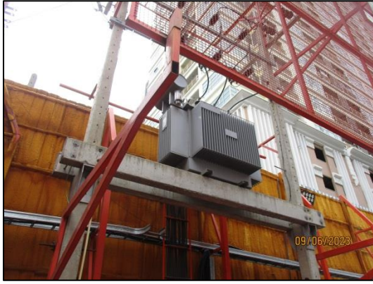
รูปที่ 33 หม้อแปลงไฟฟ้าในพื้นที่ก่อสร้าง เพื่อควบคุมปริมาณการใช้ไฟฟ้า
