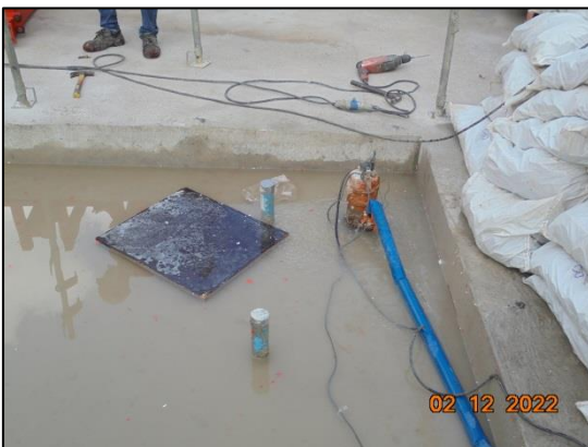
รูปที่ 26 เครื่องสูบน้ำ เพื่อสูบน้ำจากก่อสร้างชั้นใต้ดินเข้าสู่บ่อพักน้ำ ที่อยู่โดยรอบพื้นที่โครงการ
