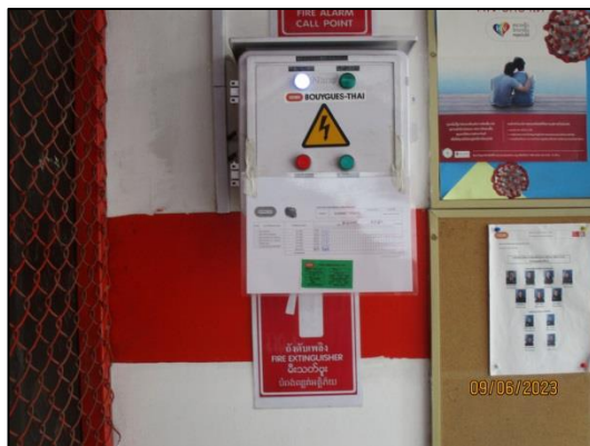
รูปที่ 41 ติดตั้งเครื่องแจ้งเหตุเตือนเพลิงไหม้ ด้วยเสียง Alarm Bell
