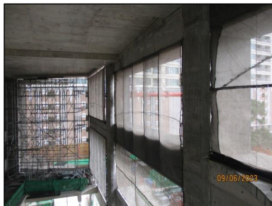
รูปที่ 13 ติดตั้ง Mesh Sheet (แบบกันไฟลาม) ตั้งแต่ชั้นล่างจนถึงชั้นสูงสุดโดยรอบอาคาร
