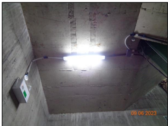
รูปที่ 32 ไฟส่องสว่าง และรางเก็บสายไฟบริเวณรั้วโครงการ โดยไม่ใช่ชุดสายพ่วงต่อพ่วงกันหลายชั้น
