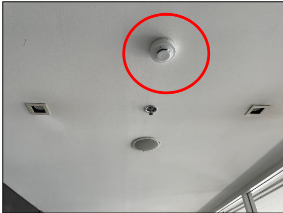
รูปที่ 3-25 เครื่องตรวจจับควัน (Smoke Detector)
