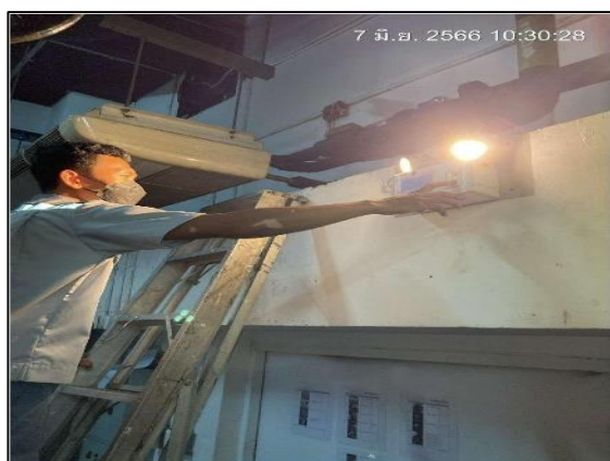
รูปที่ 3-29 กิจกรรมตรวจสอบไฟฉุกเฉิน (Emergency Light)
