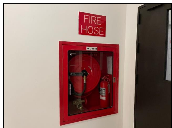
รูปที่ 3-19 ตู้เก็บสายฉีดน้ำดับเพลิงพร้อมอุปกรณ์ (FHC) / ถังดับเพลิง ชนิด A B C
