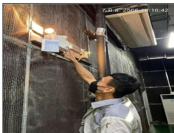
รูปที่ 3-29 กิจกรรมตรวจสอบไฟฉุกเฉิน (Emergency Light)
