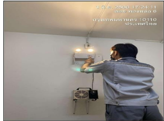
รูปที่ 3-29 (ต่อ) กิจกรรมตรวจสอบไฟฉุกเฉิน (Emergency Light)
