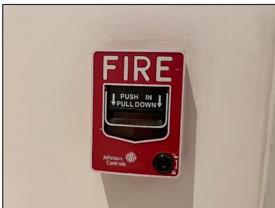
รูปที่ 3-27 เครื่องแจ้งเหตุโดยใช่มือดึง (Fire Alarm Manual Station)
