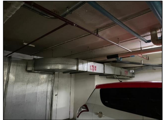
รูปที่ 3-11 ระบบระบายอากาศชั้นใต้ดิน
