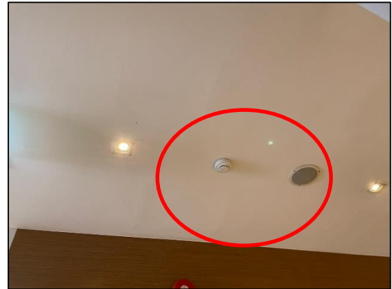
รูปที่ 3-25 เครื่องตรวจจับควัน (Smoke Detector)
