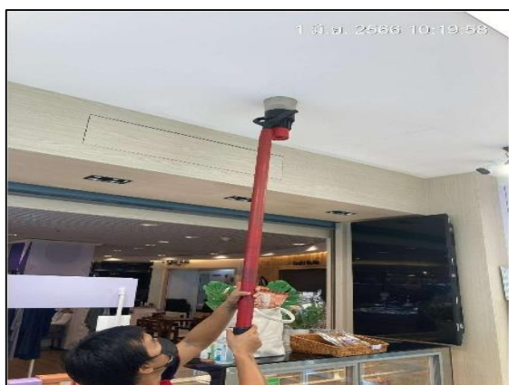
รูปที่ 3-28 กิจกรรมตรวจสอบระบบป้องกันอัคคีภัย (Fire Alarm)
