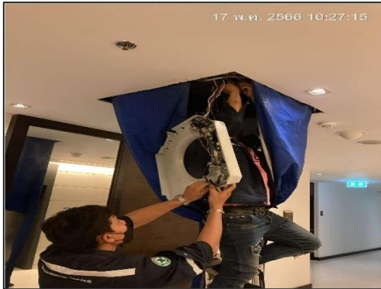
รูปที่ 3-33 กิจกรรมทำความสะอาดเครื่องปรับอากาศ
