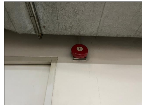
รูปที่ 3-26 กริ่งสัญญาณเตือนภัย (Alarm Bell)
