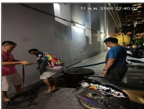
รูปที่ 3-13 กิจกรรมสูบล้างทำความสะอาดก่อนจากถึงบำบัดน้ำเสีย
