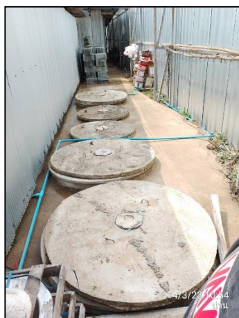
ภาพที่ 29 ระบบบำบัดน้ำเสียแบบซึมดิน
