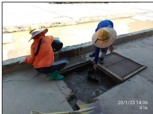
ภาพที่ 6 ปัดคัดตะกอนดินบริเวณทางเข้า-ออก
