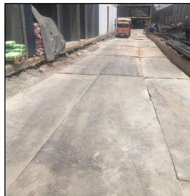
ภาพที่ 21 ปูแผ่นเหล็กภายในพื้นที่โครงการ
