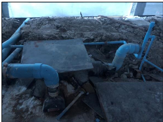
ภาพที่ 24 ระบบนำบน้ำเสียสำเร็จรูปชนิดเดิมอากาศ
