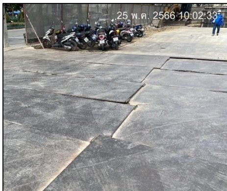
ภาพที่ 21 ปูแผ่นเหล็กภายในพื้นที่โครงการ
