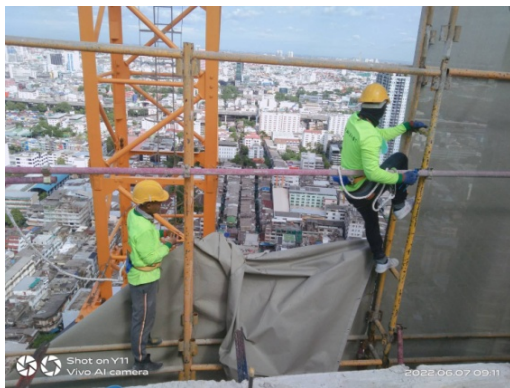
ภาพที่ 5-22 สวมใส่อุปกรณ์ป้องกันภัย เช่น เข็มขัดนิรภัยในการขึ้นที่สูง
