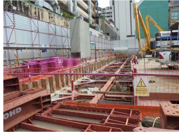
ภาพที่ 5-19 กดSheet Pile ระบบป้องกันดินพัง และติดตั้ง Inclinometer ตรวจสอบการเคลื่อนตัวของดิน
