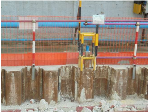
ภาพที่ 5-19 กดSheet Pile ระบบป้องกันดินพัง และติดตั้ง Inclinometer ตรวจสอบการเคลื่อนตัวของดิน
