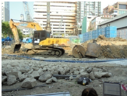
5-2 การทำเสาเข็มแบบเสาเข็มเจาะ
