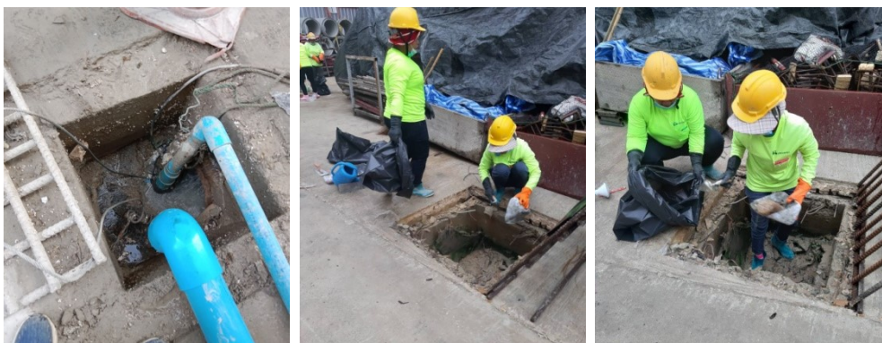
5-12 ล้างทำความสะอาดบ่อพักตะกอนและท่อระบายน้ำ
