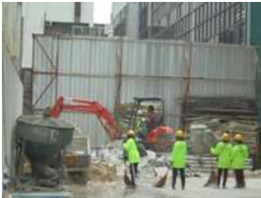
ภาพที่ 5-28 ตักเศษวัสดุก่อสร้างขนออกไปสู่ภายนอกโครงการและติดตั้งสเปรย์น้ำมา่นน้ำบริเวณด้านหลังที่ติดกับอาคารข้างเคียง
