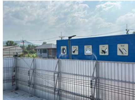
รูปที่ 1 รั้วทึบเมทัลชีท (Metal Sheet)
