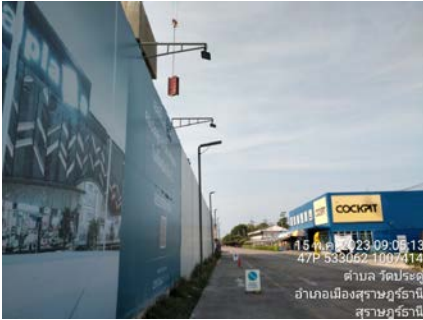
รูปที่ 1 รั้วทึบเมทัลชีท (Metal Sheet)
