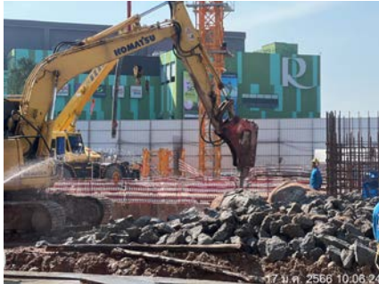
รูปที่ 38(ต่อ) คนงานฉีดพรมน้ำบริเวณที่เกิดฝุ่น
