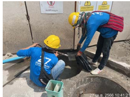
รูปที่ 14 คนงานทำความสะอาดบ่อดักขยะ
