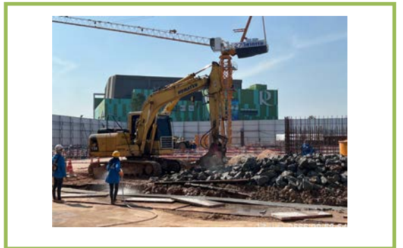
รูปที่ 38 คนงานฉีดพรมน้ำบริเวณที่เกิดฝุ่น
