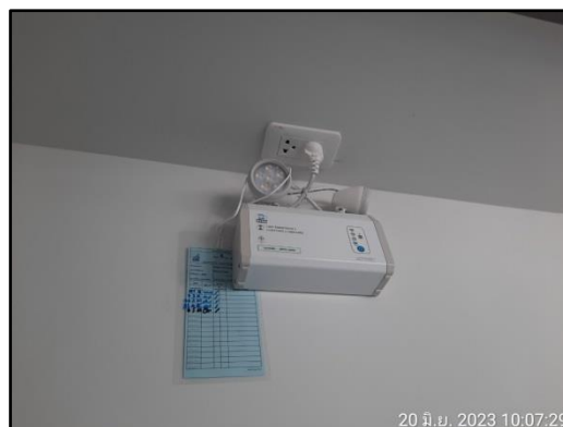
รูปที่ 38 ระบบไฟส่องสว่างฉุกเฉิน
