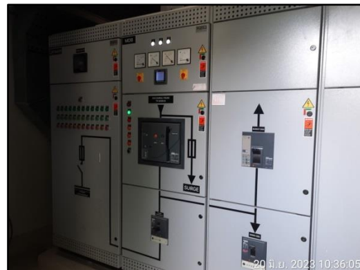
รูปที่ 36 ห้องสวิตช์บอร์ดแรงสูงชนิดติดตั้งภายในอาคาร (MDB)
