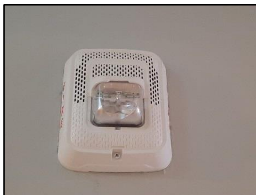
รูปที่ 49 อุปกรณ์เตือนภัยแบบใช้มือดึงและอุปกรณ์เตือนภัยแบบใช้แสงและเสียง
