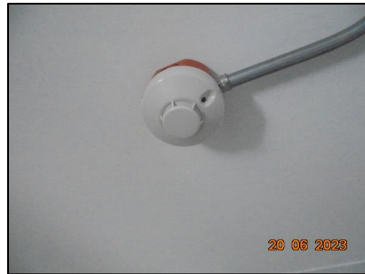
รูปที่ 50 อุปกรณ์ตรวจจับควัน
