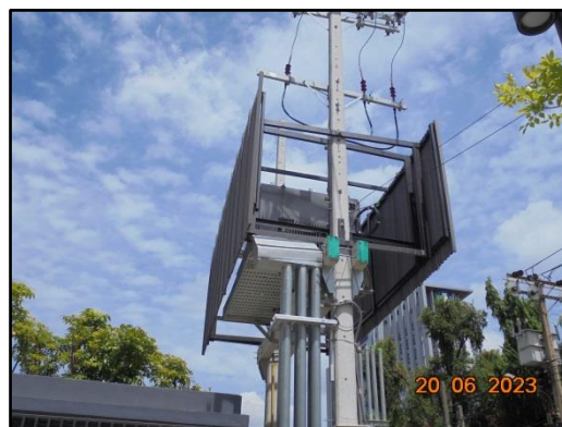
รูปที่ 39 หม้อแปลงไฟฟ้าโครงการ
