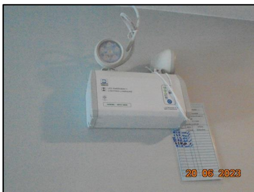
รูปที่ 38 ระบบไฟส่องสว่างฉุกเฉิน
