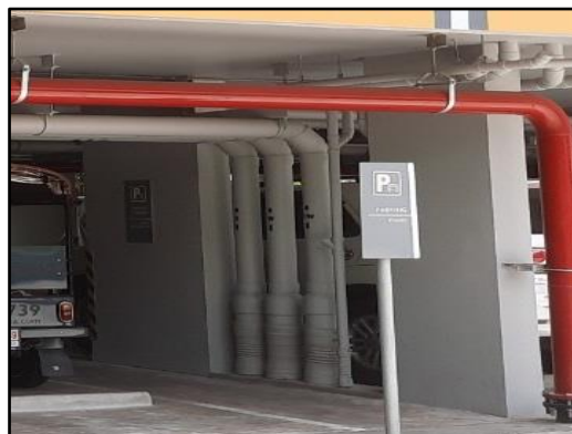
รูปที่ 46 ท่อยืนรับน้ำดับเพลิงจากหัวรับน้ำดับเพลิงภายนอกอาคาร
