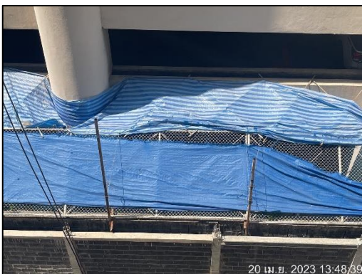
ภาพที่ 52 ติดตั้งแผ่นตาข่ายป้องกันวัตถุตกหล่น
