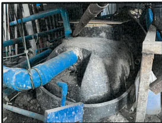
รูปที่ 3-15 ถังบำบัดน้ำเสียในพื้นที่ก่อสร้าง
