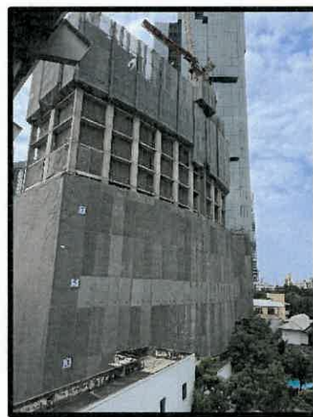
รูปที่ 3-5 ผ้าใบ Mesh sheet ชนิดกันไฟลาม คลุมโดยรอบอาคาร
