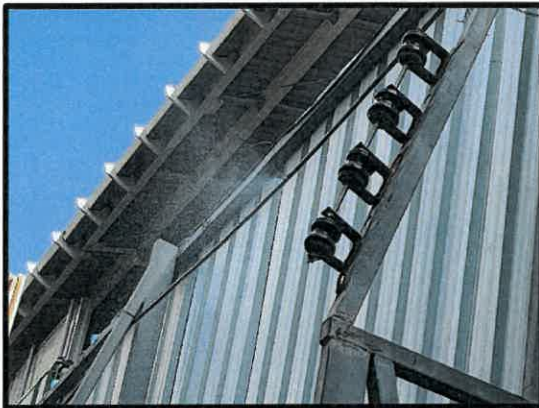
รูปที่ 3-8 สเปรย์น้ำดักฝุ่นละอองบริเวณรั้วของโครงการ และบนตัวอาคารชั้นก่อสร้าง
