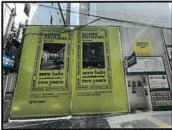
รูปที่ 3-1 รั้วทึบชั่วคราว Metal Sheet สูง 6 เมตร และม่านกัน
