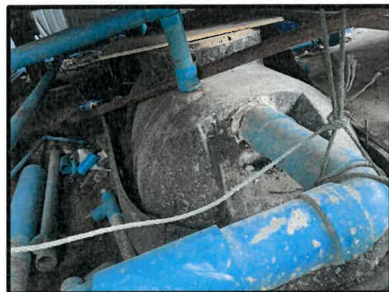
รูปที่ 3-15 ถังบำบัดน้ำเสียในพื้นที่ก่อสร้าง
