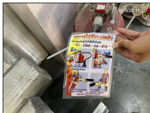
ภาพที่ 11 ถังดับเพลิง และป้ายแนะนำการการใช้อุปกรณ์
