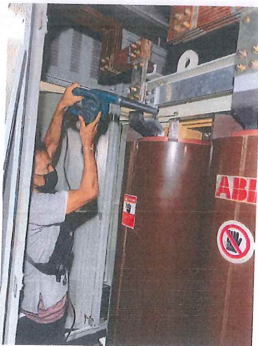
ภาพชุดที่ 2 ขณะดำเนินการทำความสะอาดรักษาสภาพหม้อแปลงไฟฟ้า
