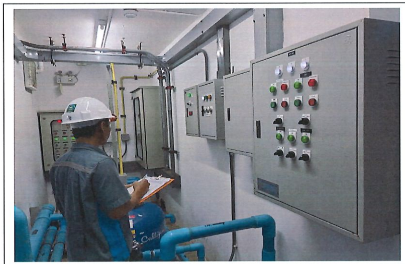
รูปที่ 29 ภาพช่างตรวจสอบเช็คระบบปั้มน้ำ / ถ้ำรองน้ำ
