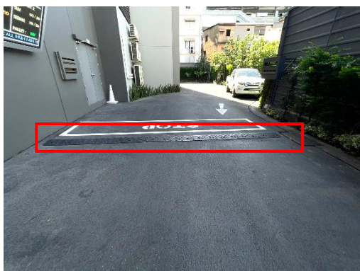
รูปที่ 3-11 การติดตั้งสันชะลอความเร็วและการติดตั้งกระຈกนูน
