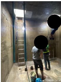
รูปที่ 3-38 ล้างทำความสะอาดถึงเก็บน้ำ เมื่อวันที่ 6-7 กุมภาพันธ์ 2566
