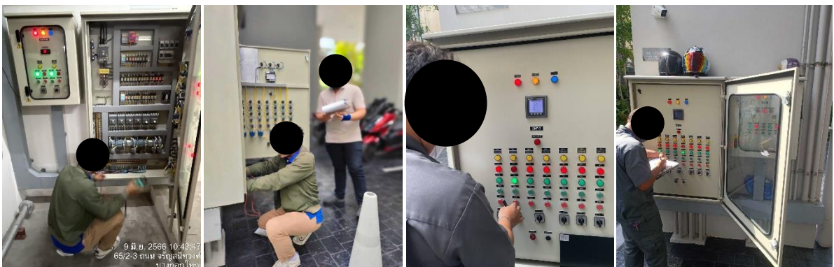
รูปที่ 3-32 ตรวจสอบตู้ควบคุมของระบบบำบัดน้ำเสีย
