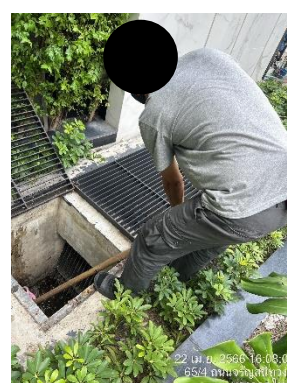
รูปที่ 3-21 ติดตั้งตะแกรงดักขยะ
