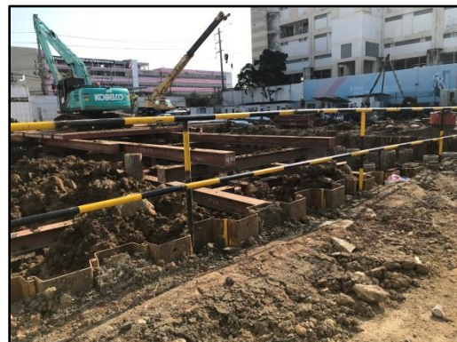
รูปที่ 3 แนวกำแพงป้องกันดิน (Sheet pile wall)
