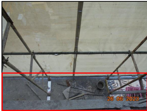
รูปที่ 78 แฝงกันกันวัสดุตกหล่น
