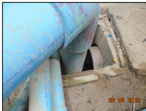
รูปที่ 10 จุลรบบรวมน้ำที่ผ่านการบำบัดก่อนระบายออกสู่ท่อระบายน้ำสาธารณะ
