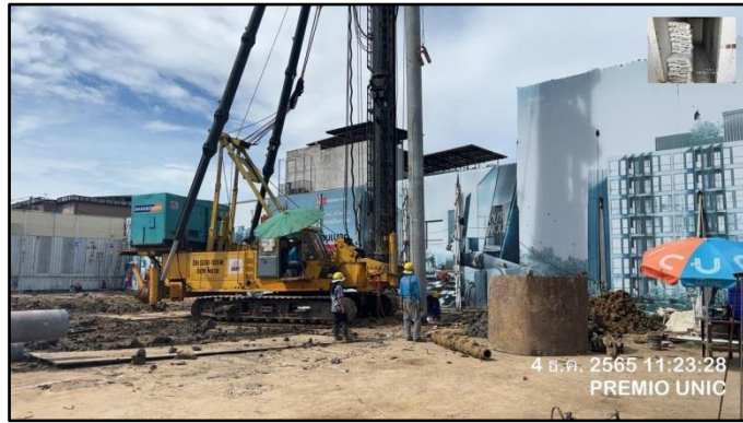
รูปที่ 33 เสาค้ำเจาะ โดยมีการติดตั้งด้วยวิธีเจาะกด (JACK IN PILE SYSTEM)
