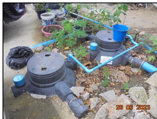
รูปที่ 40 ระบบบำบัดน้ำเสียสำเร็จรูปในพื้นที่บ้านพักคนงาน
