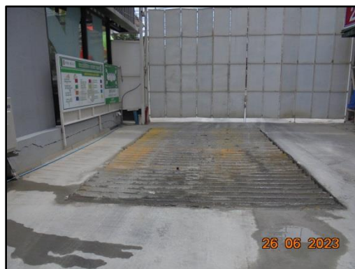
รูปที่ 45 พื้นที่ล้างล้อรถยนต์ของโครงการ
