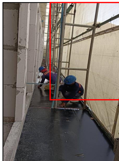
รูปที่ 79 การใช้ผ้าใบเพื่อป้องกันการกระเด็นหรือตกหล่นวัสดุ
