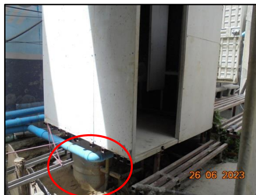
รูปที่ 39 ระบบบำบัดน้ำเสียสำเร็จรูปในพื้นที่ก่อสร้าง
