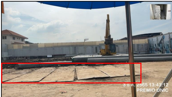
รูปที่ 34 อุปกรณ์ป้องกันความสั่นสะเทือนรองไว้ได้เครื่องจักร
