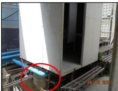
รูปที่ 1-6 ถังบำบัดน้ำเสียสำเร็จรูป
