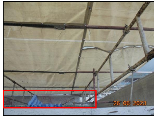
รูปที่ 78 แฝงกันกันวัสดุตกหล่น
