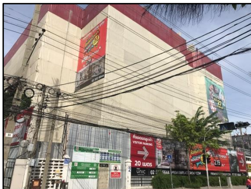
รูปที่ 79 การใช้ผ้าใบเพื่อป้องกันการกระเด็นหรือตกหล่นวัสดุ
