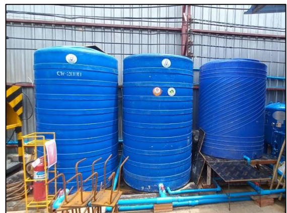
รูปที่ 2-21 ถังสำรองน้ำใช้บริเวณพื้นที่ก่อสร้าง
