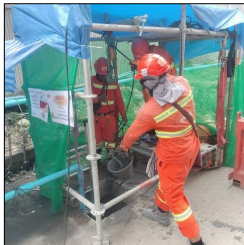
รูปที่ 39 คนงานชุดลอกตะกอนที่สะสมในบ่อพักน้ำ
