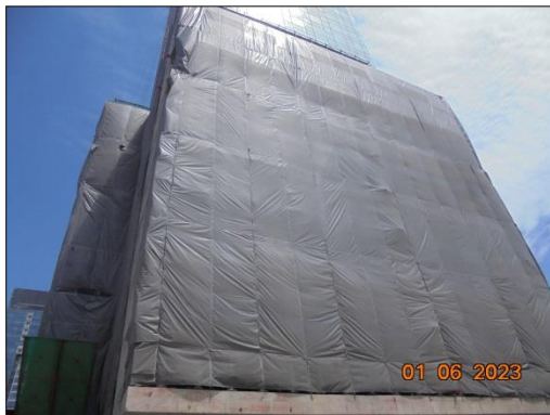
รูปที่ 4 การติดตั้ง Mesh Sheet รอบอาคาร
