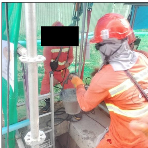
รูปที่ 39 คนงานชุดลอกตะกอนที่สะสมในบ่อพักน้ำ
