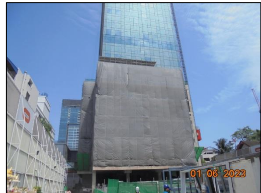
รูปที่ 4 การติดตั้ง Mesh Sheet รอบอาคาร
