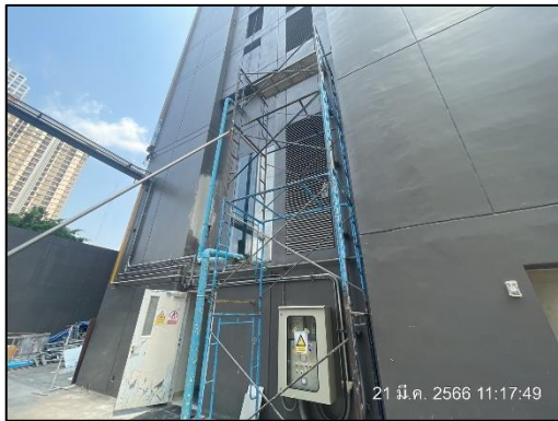
รูปที่ 56 การติดตั้งนั่งร้าน
