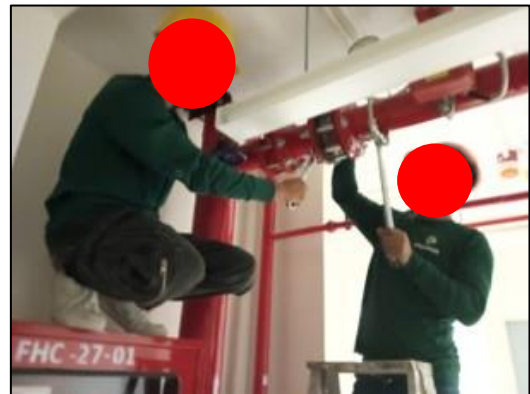
รูปที่ 82 การตรวจสอบรอยรั่วซึมของท่อประปา
