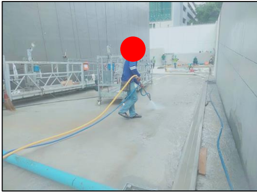
รูปที่ 69 การทำให้ผิวคอนกรีตเปียกก่อนการชุบผิวคอนกรีต
