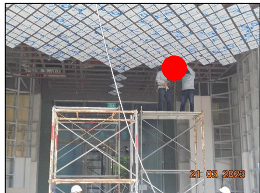
รูปที่ 76 การเก็บอุปกรณ์ เครื่องมือ และวัสดุต่างๆ บนนั่งร้านให้เรียบร้อย
