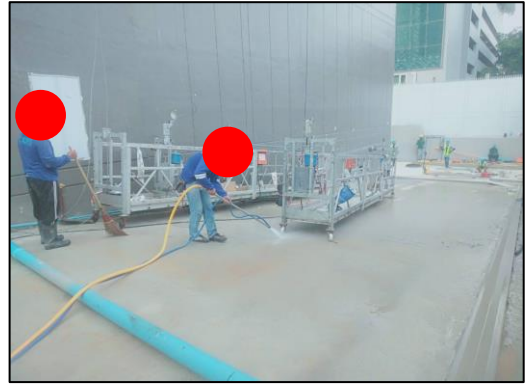
รูปที่ 69 การทำให้ผิวคอนกรีตเปียกก่อนการชุบผิวคอนกรีต
