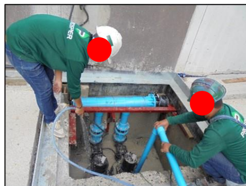
รูปที่ 78 เครื่องสูบน้ำประจำพื้นที่ก่อสร้าง
