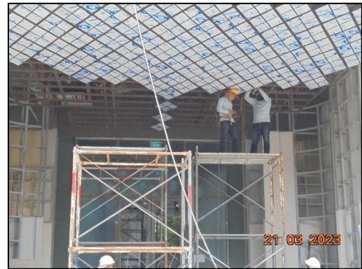
รูปที่ 56 การติดตั้งนั่งร้าน
