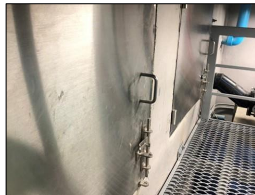
รูปที่ 37 ถังสำรองน้ำภายในโครงการ
