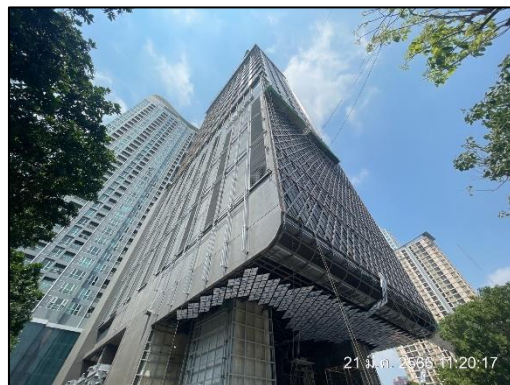
รูปที่ 50 โครงการได้รื้อถอนรั้วผ้าใบตาข่ายและผ้าใบกันฝุ่น (Mesh Sheet) ออกแล้ว
