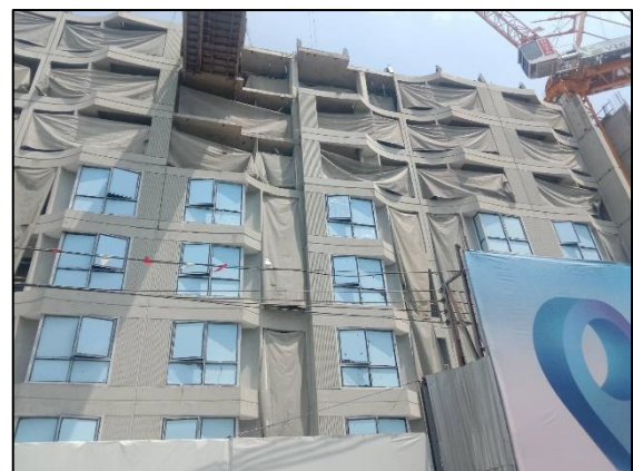
รูปที่ 2-35 Mesh Sheet (ผ้าใบก่อสร้าง)
