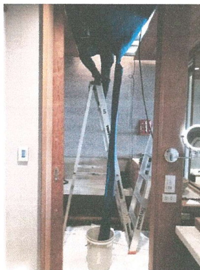
รูปภาพที่ 2.2 การทำความสะอาดเครื่องปรับอากาศ
