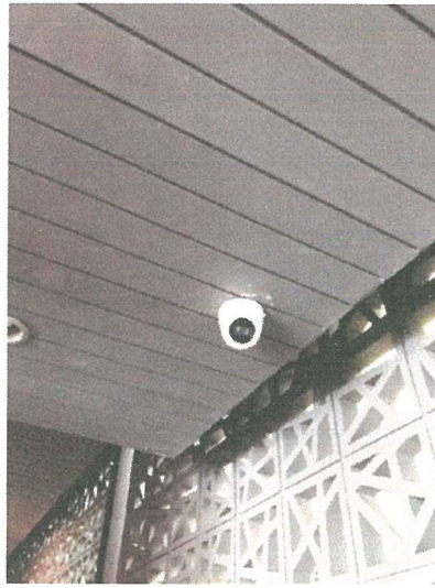
รูปภาพที่ 2.12 ระบบโทรทัศน์วงจรปิด (CCTV)
