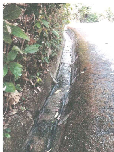
รูปภาพที่ 2.43 รางระบายน้ำและการขุดลอกตะกอน
