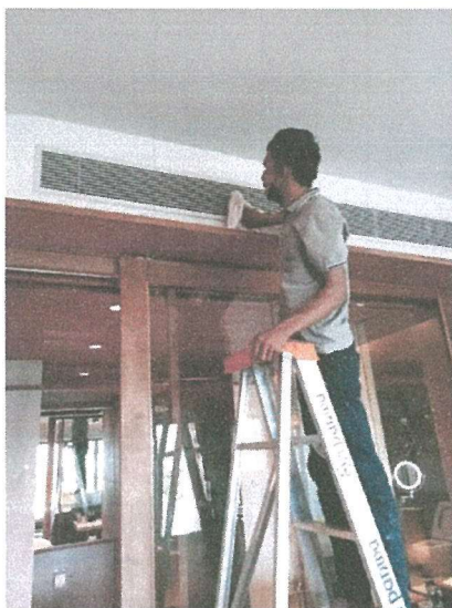
รูปภาพที่ 2.2 การทำความสะอาดเครื่องปรับอากาศ
