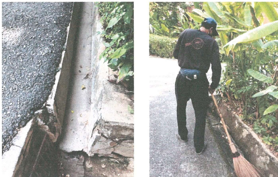
รูปภาพที่ 2.16 รางระบายน้ำและการขุดลอกตะกอน
