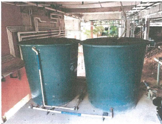
รูปภาพที่ 2.37 ถังเก็บน้ำใช้
