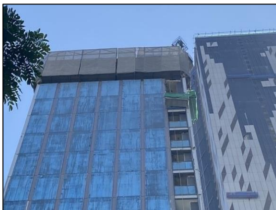
รูปที่ 2-64 Mesh Sheet (ผ้าใบก่อสร้าง)
