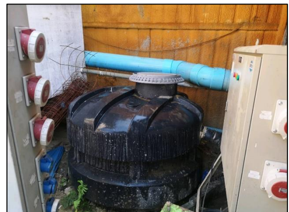
รูปที่ 2-19 ระบบบำบัดน้ำเสียสำเร็จรูป
