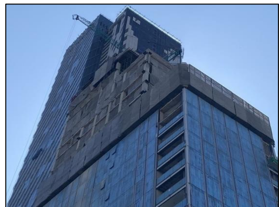
รูปที่ 2-64 Mesh Sheet (ผ้าใบก่อสร้าง)
