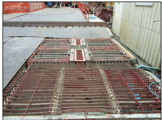
รูปที่ 2-14 กิจกรรมทำความสะอาดล้อรถบรรทุก และพื้นที่สำหรับล้างล้อรถบรรทุก
