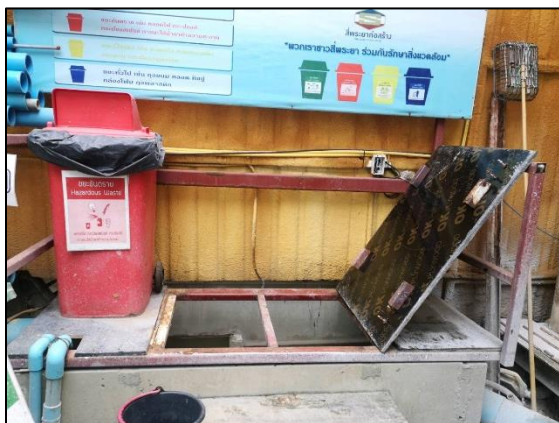
รูปที่ 2-24 บ่อดักขยะ และบ่อดักน้ำทิ้ง
