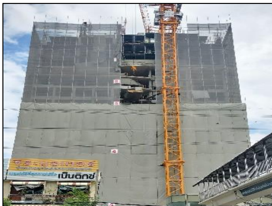
รูปที่ 2-45 Mesh Sheet
