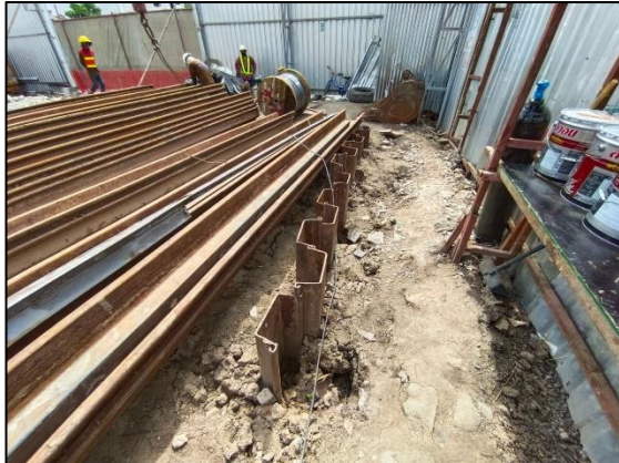
รูปที่ 2-12 Sheet Pile
