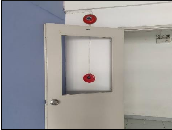
รูปที่ 2-22 สัญญาณแจ้งเหตุเพลิงไหม้
