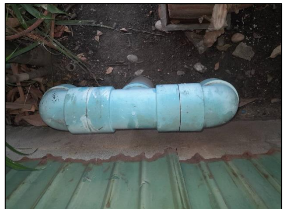
รูปที่ 2-15 ท่อระบายอากาศ
