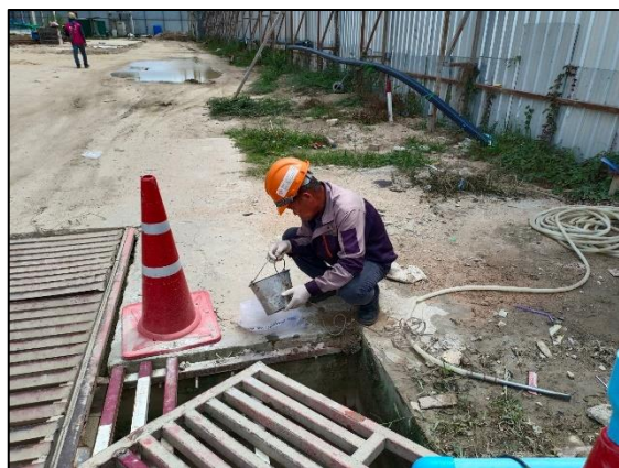
บ่อพักน้ำชั่วคราวบ่อสุดท้ายก่อนระบายน้ำออกสู่ท่อระบายน้ำสาธารณะริมถนนนาจอมเทียน ซอย 8 (พิกัด : 12°51'02.1" N, 100°54'17.9" E)
