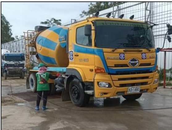
รูปที่ 2-10 กิจกรรมทำความสะอาดล้อรถบรรทุกก่อนออกนอกบริเวณโครงการ
