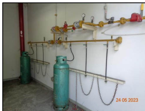
รูปที่ 18 ตำแหน่งวาล์วปิดก๊าส สะพานไฟ สำหรับตัดกระแสไฟฟ้าที่มองเห็นได้อย่างชัดเจน
