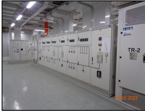
รูปที่ 39 หม้อแปลงไฟฟ้าแยกต่างหากจากหม้อแปลงไฟฟ้าของชุมชน
