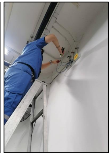
รูปที่ 34 ติดตั้งอุปกรณ์เดินสายไฟฟ้า รวมถึงสายสัญญาณทางไฟฟ้าสื่อสารต่างๆ
