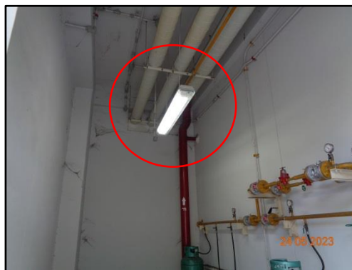
รูปที่ 37 เลือกใช้โคมไฟที่มีแผ่นสะท้อนแสง
