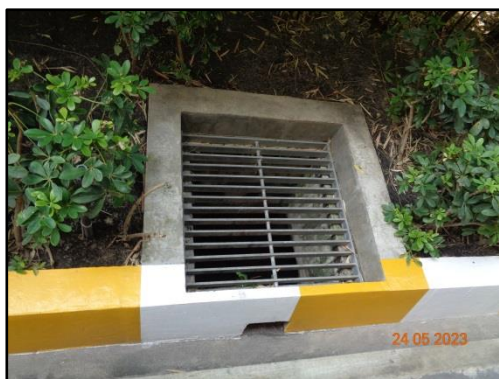
รูปที่ 53 ท่อระบายน้ำเป็นท่อระบายน้ำคอนกรีตเสริมเหล็ก
