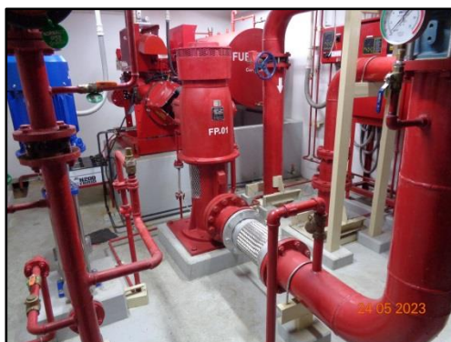
รูปที่ 62 ระบบน้ำสำรองดับเพลิง ในถังเก็บน้ำใต้ดิน
