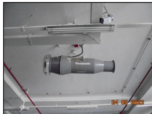
รูปที่ 7 พัดลมดูดอากาศ บริเวณลานจอดรถยนต์ชั้นใต้ดิน
