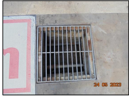
รูปที่ 44 รางระบายน้ำ เพื่อรวบรวมน้ำเสียจากการชะล้าง
