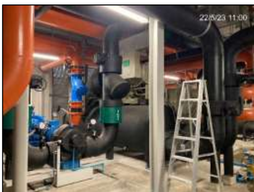
ภาพที่ 25 ระบบปรับอากาศแบบศูนย์รวม (Water Cooled Chiller) และเครื่องมือฆ่าเชื้อโรคน้ำที่ใช้ในการหล่อเย็น
