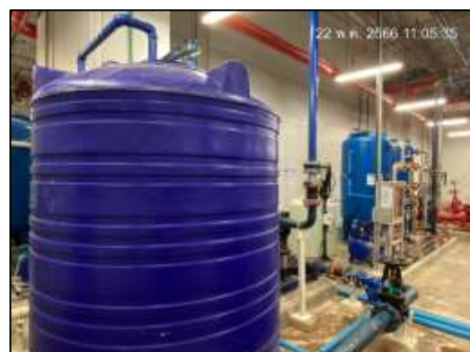
ภาพที่ 12 ถังสำรองน้ำใช้ และน้ำสำรองดับเพลิง
