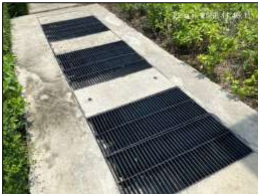
ภาพที่ 15 ตะแกรงดักขยะบริเวณบ่อพักน้ำสุดท้าย ก่อนระบายออกสู่สาธารณะ
