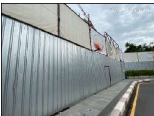
ภาพที่ 2 รั้ว Metal Sheet สูง 6 เมตร บริเวณแนวเขตพื้นที่โครงการด้านที่ติดกับแนวอาคาร และด้านที่ติดกับถนน
