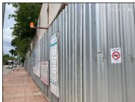
ภาพที่ 2 รั้ว Metal Sheet สูง 6 เมตร บริเวณแนวเขตพื้นที่โครงการด้านที่ติดกับแนวอาคาร และด้านที่ติดกับถนน
