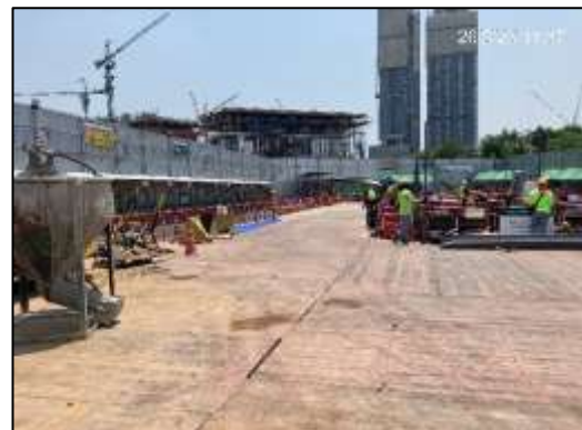
ภาพที่ 16 ปูแผ่นเหล็กทางรถวิ่ง
