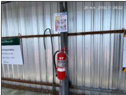
ภาพที่ 44 ดังคับเพลิง และป้ายแนะนำการใช้
