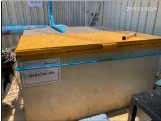
ภาพที่ 21 ระบบบำบัดน้ำเสียสำเร็จรูปชนิดเติมอากาศ
