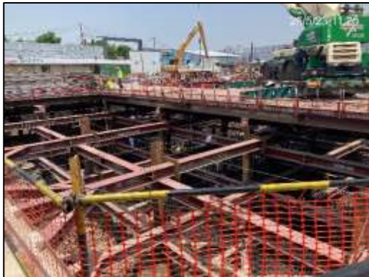
ภาพที่ 19 Sheet Pile/Pile Wall และระบบค้ำยันเหล็ก
