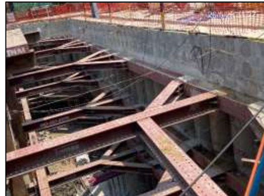
ภาพที่ 19 Sheet Pile/Pile Wall และระบบค้ำยันเหล็ก
