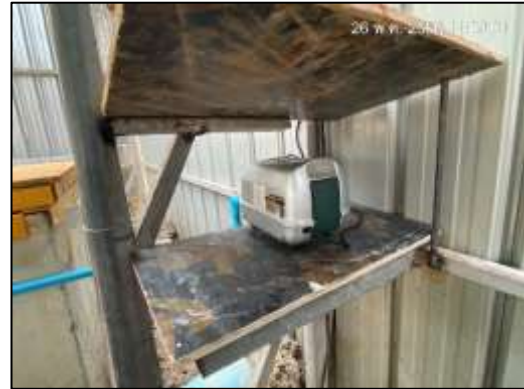
ภาพที่ 21 ระบบบำบัดน้ำเสียสำเร็จรูปชนิดเติมอากาศ
