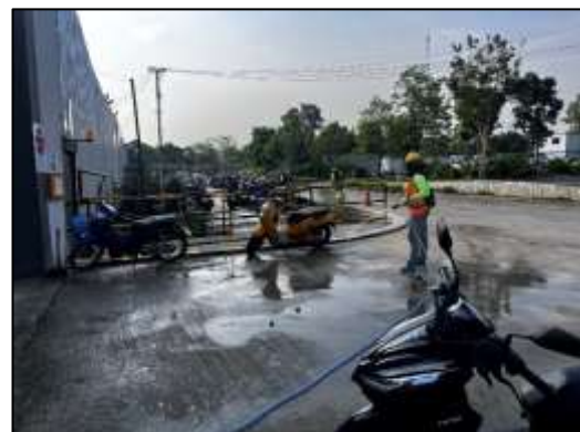
ภาพที่ 12 คนงานฉีดพรมน้ำและกวาดทำความสะอาดบริเวณพื้นที่ก่อสร้าง
