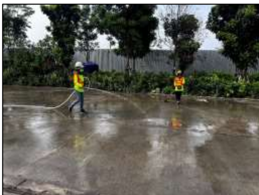
ภาพที่ 12 คนงานฉีดพรมน้ำและกวาดทำความสะอาดบริเวณพื้นที่ก่อสร้าง
