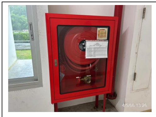
รูปที่ 2.14-2 ตู้สายฉีดน้ำดับเพลิง
