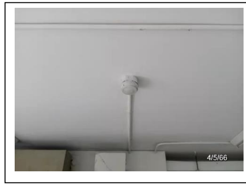
รูปที่ 2.14-7 เครื่องตรวจจับความร้อน
