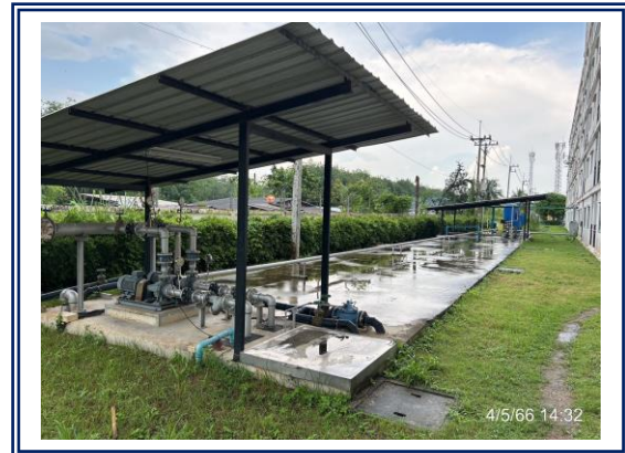
รูปที่ 3.1-18 ระบบสำรองน้ำใช้ภายในโครงการ
