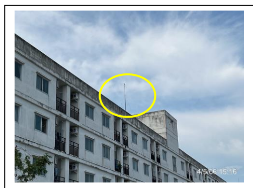
รูปที่ 2.14-11 ระบบป้องกันอันตรายจากฟ้าผ่า
